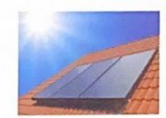
Erfahrungswerte zeigen, dass mit einer Solarthermieanlage bis zu 70% der benötigten Energie zur Trinkwassererwärmung und bis zu
